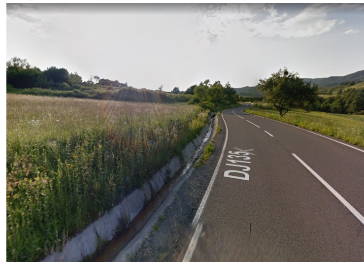
Modernizarea DJ135 Măgherani – Sărățeni
